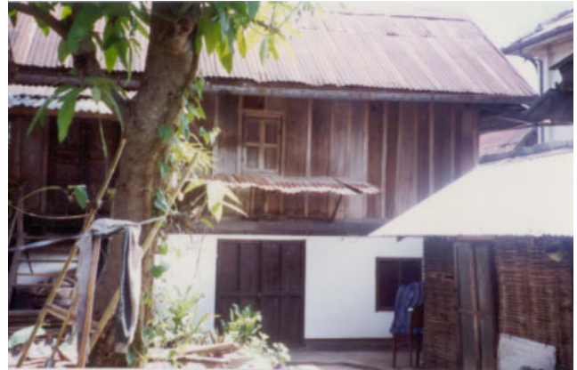
ປະເພດ Typologie ຮູບບ້ານ Village ເລກທີເຮືອນ No de maison ວັດສະດຸກໍ່ສ້າງ Matériaux de construction ນ້ຳເບີບັນຊີອະນຸລັກ No inventaire 116
