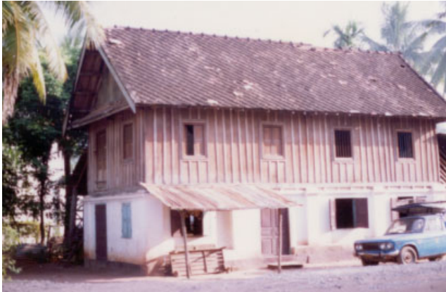
ປະເພດ Typologie ຮູ້ບ້ານ Village ເທດຫຼວງ THAT LUANG ເລກທີ່ເຮືອນ No de maison 89 ວັດສະດຸສ້າງ Matériaux de construction BBC ນ້ຳເບີບັນຊີອະນຸລັກ No inventaire 247
