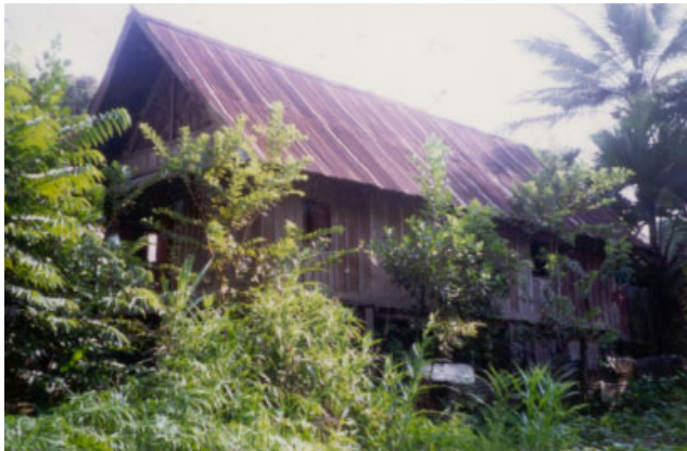
ປະເພດ Typologie ຊຸ້ງບ້ານ Village ເລກທີເຮືອນ No de maison ວັດສະດຸກໍ່ສ້າງ Matériaux de construction ນ້ຳເບີບັນຊີອະນຸລັກ No inventaire CHOUM KHONG 21/7 B 21
