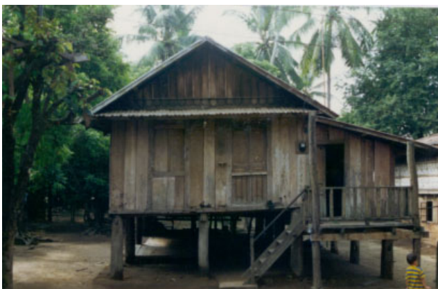
ປະເພດ Typologie ຊຸມຊົນ Village ຟັນຫຼວງ PHAN LUANG ເລກທີ່ເຮືອນ No de maison 26 ວັດສະດຸກໍ່ສ້າງ Matériaux de construction B ນ້ຳເບີກໍ່ສ້າງ No inventaire 71
