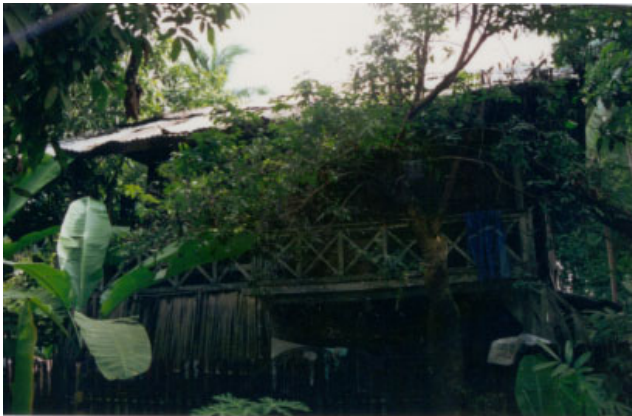
ປະເພດ Typologie ຊຸມຊົນ Village ຟັນຫຼວງ PHAN LUANG ເລກທີ່ເຮືອນ No de maison 24 ວັດສະດຸກໍ່ສ້າງ Matériaux de construction B ນ້ຳເບີກໍ່ສ້າງ No inventaire 69
