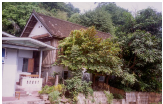
ປະເພດ Typologie ຮູ້ບ້ານ Village ອາໄຟ APHAY ເລກທີ່ເຮືອນ No de maison 13/3 ວັດສະດຸສ້າງ Matériaux de construction BBC ນ້ຳເບີບັນຊີອະນຸລັກ No inventaire 252
