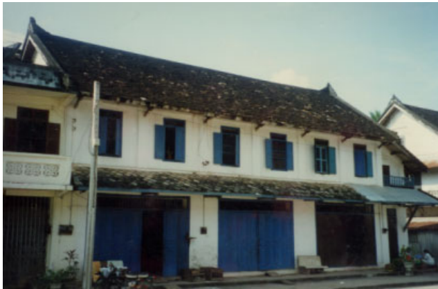
ປະເພດ Typologie ຊຸ້ງບ້ານ Village ເລກທີເຮືອນ No de maison ວັດສະດຸກໍ່ສ້າງ Matériaux de construction ນ້ຳເບີບັນຊີອະນຸລັກ No inventaire ຈຸນຄ່ອງ CHOUM KHONG 10-12/7 BBC 223
