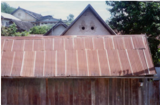
ປະເພດ Typologie ຮູບບ້ານ Village ເລກທີເຮືອນ No de maison ວັດສະດຸກໍ່ສ້າງ Matériaux de construction ນ້ຳເບີບັນຊີອະນຸລັກ No inventaire 117
