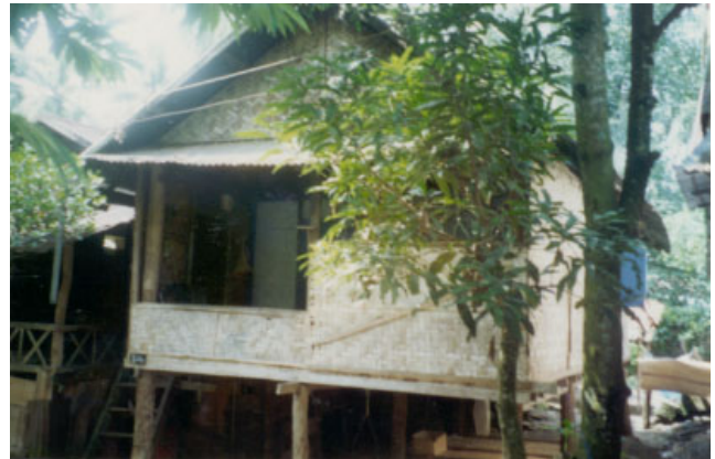
ປະເພດ Typologie ຊຸ້ງບ້ານ Village ເລກທີເຮືອນ No de maison ວັດສະດຸກໍ່ສ້າງ Matériaux de construction ນ້ຳເບີບັນຊີອະນຸລັກ No inventaire CHOUM KHONG 24/7 B 22
