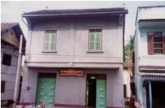
ປະເພດ Typologie ຊຸມນ້ອນ Village ເລກທີ່ເຮືອນ No de maison ວັດສະດຸກໍ່ສ້າງ Matériaux de construction ນ້ຳເບີບັນຊີອະນຸລັກ No inventaire 321
