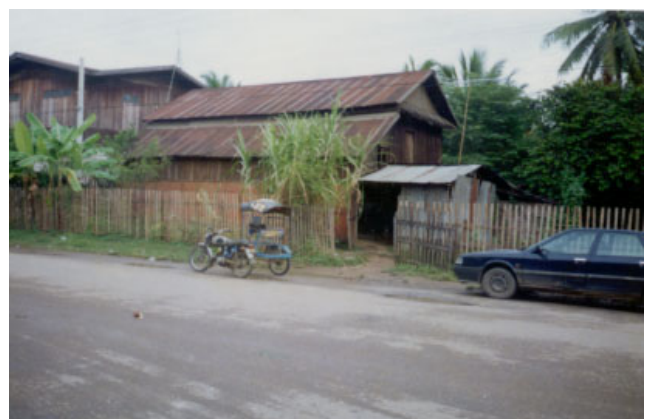
ປະເພດ Typologie ຊຸມຊົນ Village ອາໄພ APHAY ເລກທີເຮືອນ No de maison 63/3 ວັດສະດຸກໍ່ສ້າງ Matériaux de construction B ນ້ຳເບີກໍ່ສ້າງ No inventaire 54
