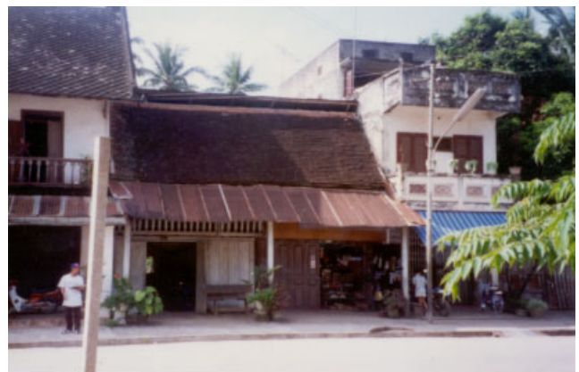
ປະເພດ Typologie ຮູບບ້ານ Village ເລກທີເຮືອນ No de maison ວັດສະດຸກໍ່ສ້າງ Matériaux de construction ນ້ຳເບີບັນຊີອະນຸລັກ No inventaire 120
