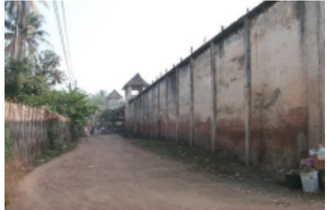
ປະເພດ Typologie ຊຸມຊົນ Village ເຮືອນ No de maison ວັດສະດຸສ້າງ Matériaux de construction ນ້ຳເບີບັນຊີອະນຸລັກ No inventaire MANO - BC 344
