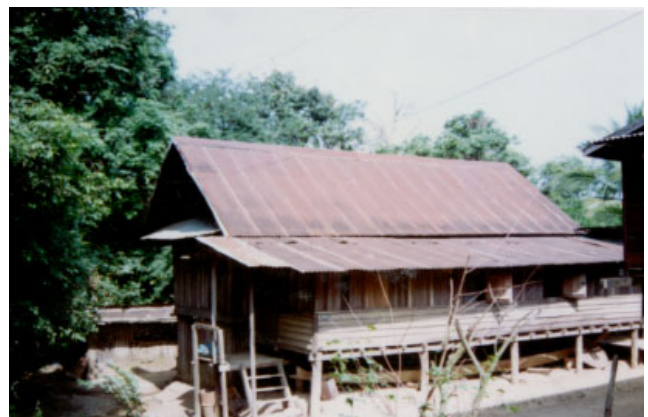
ປະເພດ Typologie ຊຸມຊົນ Village ຟັນຫຼວງ PHAN LUANG ເລກທີ່ເຮືອນ No de maison 88/10 ວັດສະດຸກໍ່ສ້າງ Matériaux de construction B ນ້ຳເບີກໍ່ສ້າງ No inventaire 72
