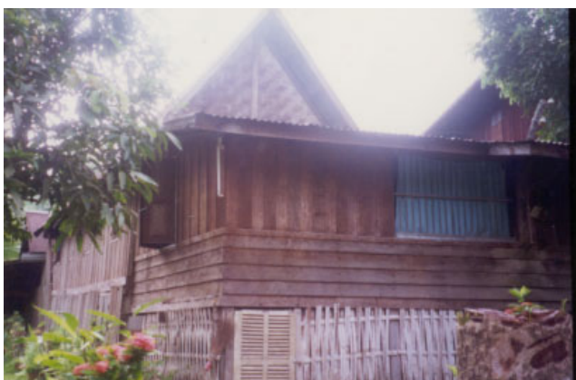
ປະເພດ Typologie ຊຸມຊົນ Village ອາໄພ APHAY ເລກທີເຮືອນ No de maison 64/3 ວັດສະດຸກໍ່ສ້າງ Matériaux de construction B ນ້ຳເບີກໍ່ສ້າງ No inventaire 53
