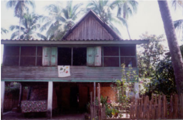
ປະເພດ Typologie ຮູ້ບ້ານ Village ເລກທີເຮືອນ No de maison ວັດສະດຸກໍ່ສ້າງ Matériaux de construction ນ້ຳເບີກໍ່ສ້າງ No inventaire HOUA XIENG 93/1 B 37
