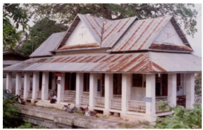
ປະເພດ Typologie ຊຸມນ້ອນ Village ເລກທີ່ເຮືອນ No de maison ວັດສະດຸກໍ່ສ້າງ Matériaux de construction ນ້ຳເບີບັນຊີອະນຸລັກ No inventaire 322
