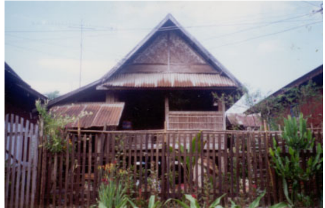
ປະເພດ Typologie ຮູ້ບ້ານ Village ເລກທີເຮືອນ No de maison ວັດສະດຸກໍ່ສ້າງ Matériaux de construction ນ້ຳເບີກໍ່ສ້າງ No inventaire HOUA XIENG 37/1 B 38
