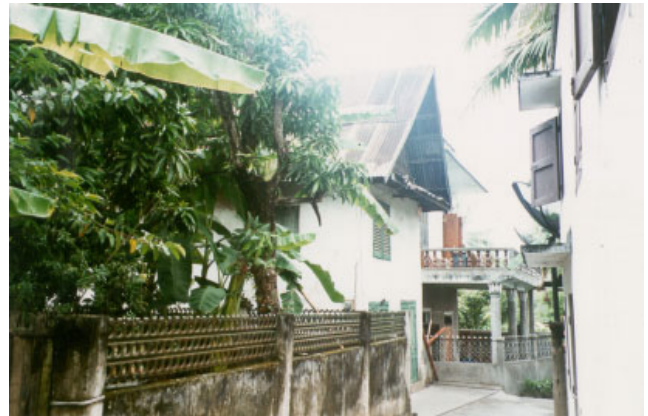
ປະເພດ Typologie ຮູບບ້ານ Village ຄິລີ KHILI ເລກທີເຮືອນ No de maison 38/2 ວັດສະດຸກໍ່ສ້າງ Matériaux de construction BT ນ້ຳເບີບັນຊີອະນຸລັກ No inventaire 106
