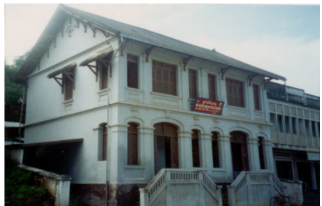
ປະເພດ Typologie ຊຸມນ້ອນ Village ເລກທີ່ເຮືອນ No de maison ວັດສະດຸກໍ່ສ້າງ Matériaux de construction ນ້ຳເບີບັນຊີອະນຸລັກ No inventaire 324
