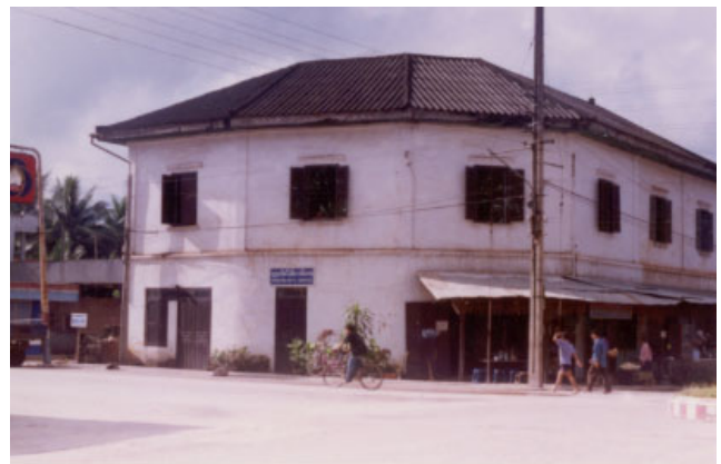
ປະເພດ Typologie ຮູບບ້ານ Village ເລກທີ່ເຮືອນ No de maison ວັດສະດຸກໍ່ສ້າງ Matériaux de construction ນ້ຳເບີບັນຊີອະນຸລັກ No inventaire 364
