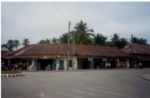
ປະເພດ Typologie ຮູບບ້ານ Village ເລກທີ່ເຮືອນ No de maison ວັດສະດຸກໍ່ສ້າງ Matériaux de construction ນ້ຳເບີບັນຊີອະນຸລັກ No inventaire 363
