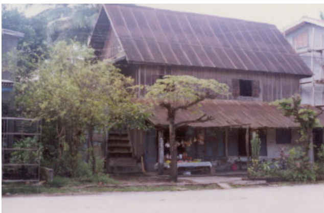
ປະເພດ Typologie ຊຸມຊົນ Village ວຽງແກ້ວ VIENG KEO ເລກທີ່ເຮືອນ No de maison 89/3 ວັດສະດຸສ້າງ Matériaux de construction BT ນ້ຳເບີທີ່ຊຶ່ງຂະໜາດ No inventaire 143
