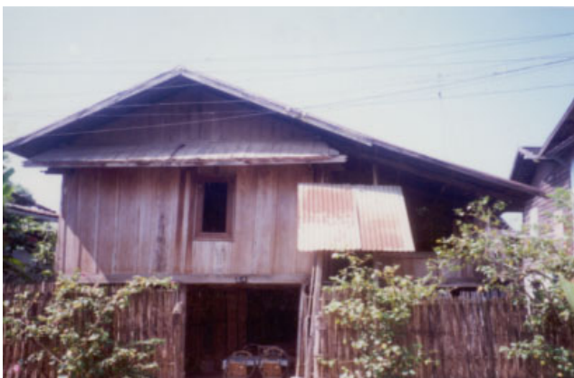
ປະເພດ Typologie ຮູ້ບ້ານ Village ເລກທີເຮືອນ No de maison ວັດສະດຸກໍ່ສ້າງ Matériaux de construction ນ້ຳເບີກໍ່ສ້າງ No inventaire VAT THAT 3/2 B 41
