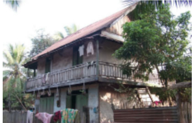
ປະເພດ Typologie ຊຸງໜອງ HOUA XIENG ເລກທີ່ເຮືອນ No de maison 92/1 ວັດສະດຸກໍ່ສ້າງ Matériaux de construction BT ນ້ຳເບີກໍ່ສ້າງ No inventaire 164
