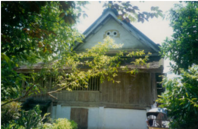
ປະເພດ Typologie ຮູ້ບ້ານ Village ໝື່ນນາ MEUNNA ເລກທີເຮືອນ No de maison 29/5 ວັດສະດຸກໍ່ສ້າງ Matériaux de construction BBC ນ້ຳເບີກໍ່ສ້າງ No inventaire 267
