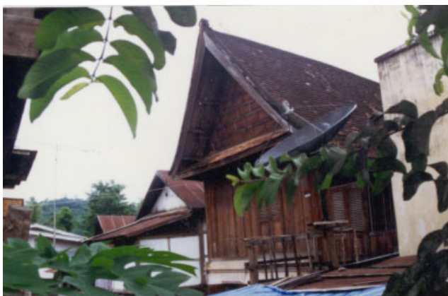
ປະເພດ Typologie ໂພນເຮືອງ Village PHONE HEUANG ເລກທີເຮືອນ No de maison 84/3 ວັດສະດຸກໍ່ສ້າງ Matériaux de construction BBC ນ້ຳເບີບັນຊີອະນຸລັກ No inventaire 197
