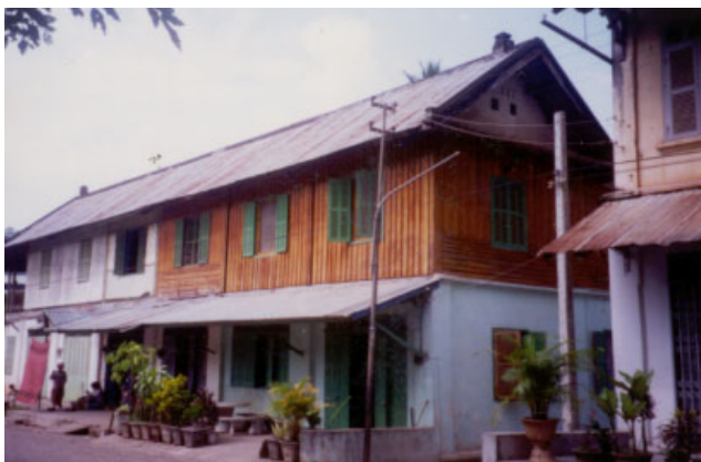
ປະເພດ Typologie ຊຸ້ງບ້ານ Village ເລກທີເຮືອນ No de maison ວັດສະດຸກໍ່ສ້າງ Matériaux de construction ນ້ຳເບີບັນຊີອະນຸລັກ No inventaire ຈຸນຄ່ອງ CHOUM KHONG 36-39/7 BBC 227
