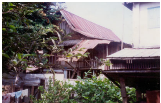
ປະເພດ Typologie ຮູບບ້ານ Village ຊຽງມ່ວນ XIENG MOUANE ເລກທີ່ເຮືອນ No de maison 110/6 ວັດສະດຸກໍ່ສ້າງ Matériaux de construction B ນ້ຳເບີບັນຊີອະນຸລັກ No inventaire 18
