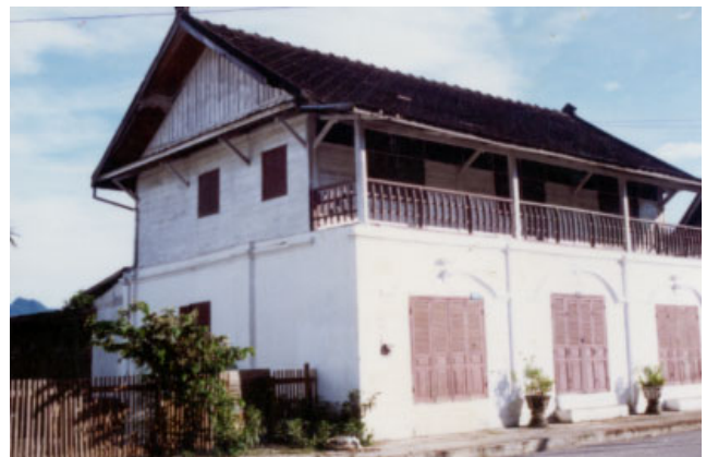
ປະເພດ Typologie ຄິລີ Village KHILI ເລກທີເຮືອນ No de maison 43/2 ວັດສະດຸກໍ່ສ້າງ Matériaux de construction BBC ນ້ຳເບີບັນຊີອະນຸລັກ No inventaire 196
