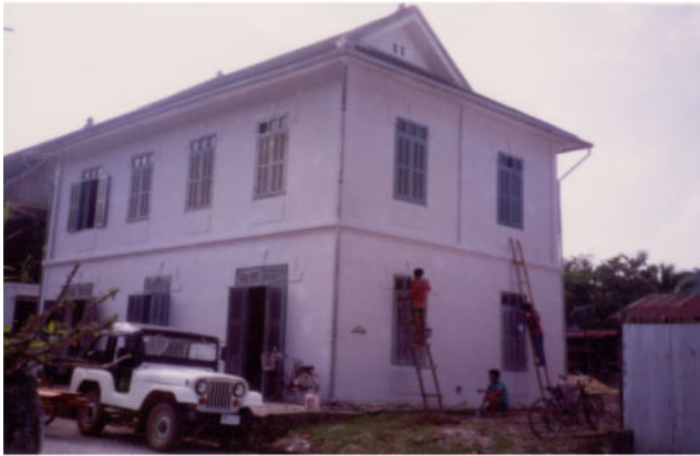
ປະເພດ Typologie ຊຸມນ້ອນ Village ເລກທີ່ເຮືອນ No de maison ວັດສະດຸກໍ່ສ້າງ Matériaux de construction ນ້ຳເບີບັນຊີອະນຸລັກ No inventaire 319
