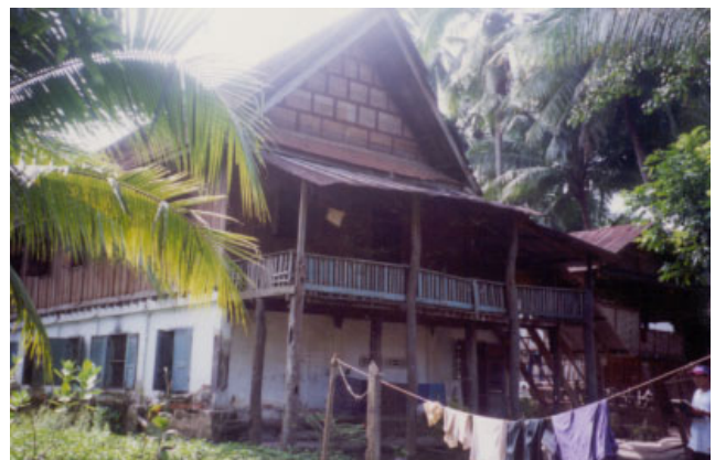
ປະເພດ Typologie ຊຸ້ງບ້ານ Village ເລກທີເຮືອນ No de maison ວັດສະດຸກໍ່ສ້າງ Matériaux de construction ນ້ຳເບີບັນຊີອະນຸລັກ No inventaire ຈຸນຄ່ອງ CHOUM KHONG 26/7 BBC 228
