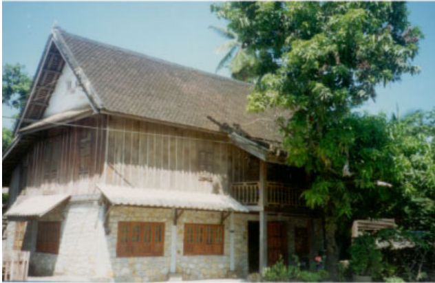
ປະເພດ Typologie ຮູ້ບ້ານ Village ໝື່ນນາ MEUNNA ເລກທີເຮືອນ No de maison 19/5 ວັດສະດຸກໍ່ສ້າງ Matériaux de construction BBC ນ້ຳເບີກໍ່ສ້າງ No inventaire 265
