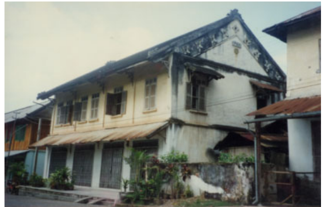
ປະເພດ Typologie ຊຸ້ງບ້ານ Village ເລກທີເຮືອນ No de maison ວັດສະດຸກໍ່ສ້າງ Matériaux de construction ນ້ຳເບີບັນຊີອະນຸລັກ No inventaire ຈຸນຄ່ອງ CHOUM KHONG 25/7 BBC 226
