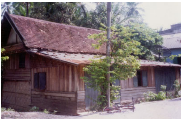
ປະເພດ Typologie ຮູບບ້ານ Village ຊຽງມ່ວນ XIENG MOUANE ເລກທີ່ເຮືອນ No de maison 76/6 ວັດສະດຸກໍ່ສ້າງ Matériaux de construction B ນ້ຳເບີບັນຊີອະນຸລັກ No inventaire 17
