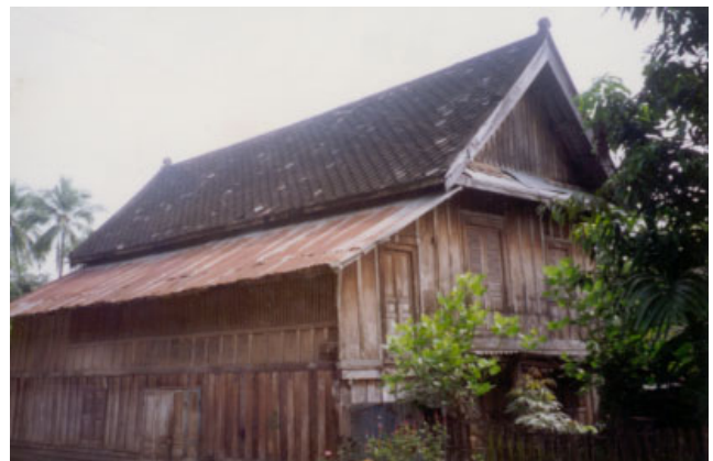
ປະເພດ Typologie ຊຸມຊົນ Village ອາໄພ APHAY ເລກທີເຮືອນ No de maison 24/3 ວັດສະດຸກໍ່ສ້າງ Matériaux de construction B ນ້ຳເບີກໍ່ສ້າງ No inventaire 52
