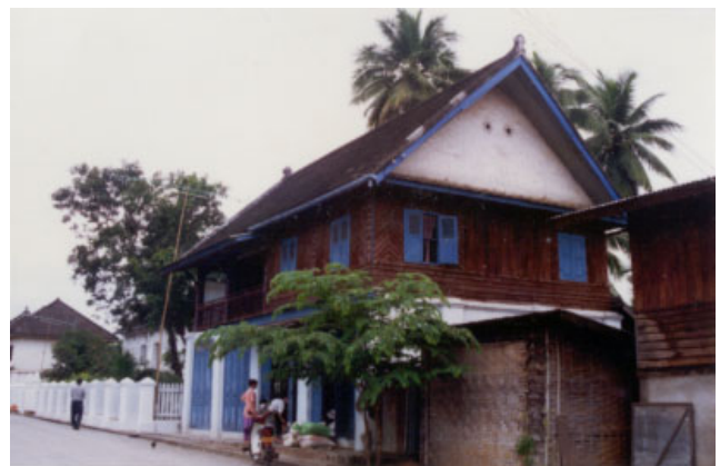
ປະເພດ Typologie ໂພນເຮືອງ Village PHONE HEUANG ເລກທີເຮືອນ No de maison 92/3 ວັດສະດຸກໍ່ສ້າງ Matériaux de construction BBC ນ້ຳເບີບັນຊີອະນຸລັກ No inventaire 198
