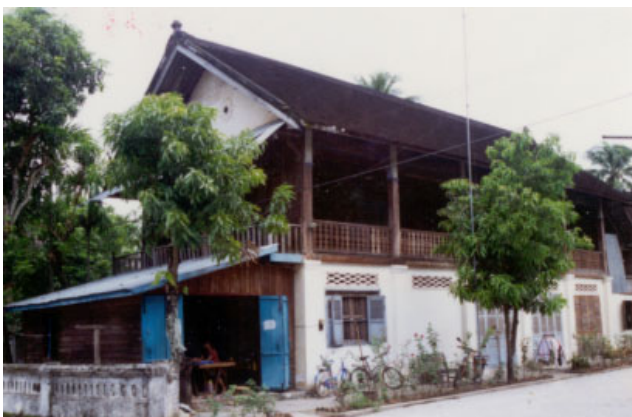
ປະເພດ Typologie ຮູບບ້ານ Village ໂພນເຮືອງ PHONE HEUANG ເລກທີເຮືອນ No de maison 102/3 ວັດສະດຸກໍ່ສ້າງ Matériaux de construction BBC ນ້ຳເບີບັນຊີອະນຸລັກ No inventaire 203
