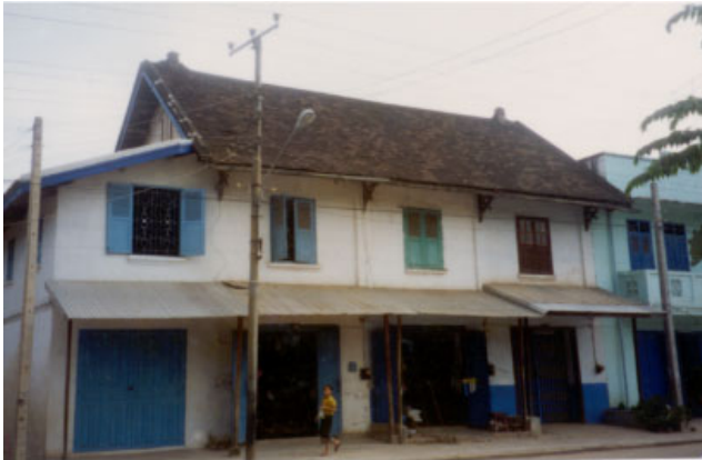
ປະເພດ Typologie ຮູບບ້ານ Village ເວີຂຸນ VIXUN ເລກທີ່ເຮືອນ No de maison 32-34/4 ວັດສະດຸກໍ່ສ້າງ Matériaux de construction BC ນ້ຳເບີບັນຊີອະນຸລັກ No inventaire 385
