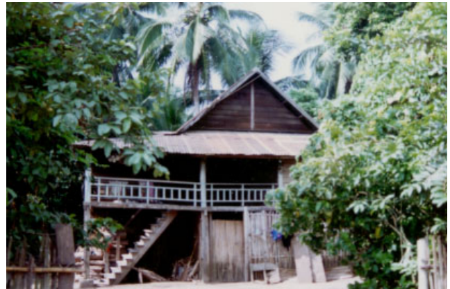
ປະເພດ Typologie ຊຸມຊົນ Village ຟັນຫຼວງ PHAN LUANG ເລກທີ່ເຮືອນ No de maison 17 ວັດສະດຸກໍ່ສ້າງ Matériaux de construction B ນ້ຳເບີກໍ່ສ້າງ No inventaire 70
