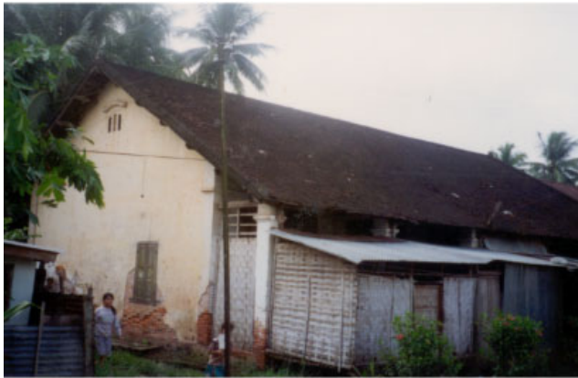
ປະເພດ Typologie ຮູບບ້ານ Village ເລກທີ່ເຮືອນ No de maison ວັດສະດຸກໍ່ສ້າງ Matériaux de construction ນ້ຳເບີບັນຊີອະນຸລັກ No inventaire 361
