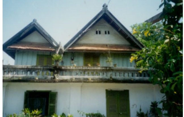
ປະເພດ Typologie ຮູ້ບ້ານ Village ໝື່ນນາ MEUNNA ເລກທີເຮືອນ No de maison 28/5 ວັດສະດຸກໍ່ສ້າງ Matériaux de construction BBC ນ້ຳເບີກໍ່ສ້າງ No inventaire 266
