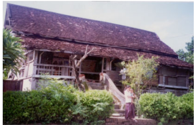
ປະເພດ Typologie ຮູບບ້ານ Village ເລກທີເຮືອນ No de maison ວັດສະດຸກໍ່ສ້າງ Matériaux de construction ນ້ຳເບີບັນຊີອະນຸລັກ No inventaire 118
