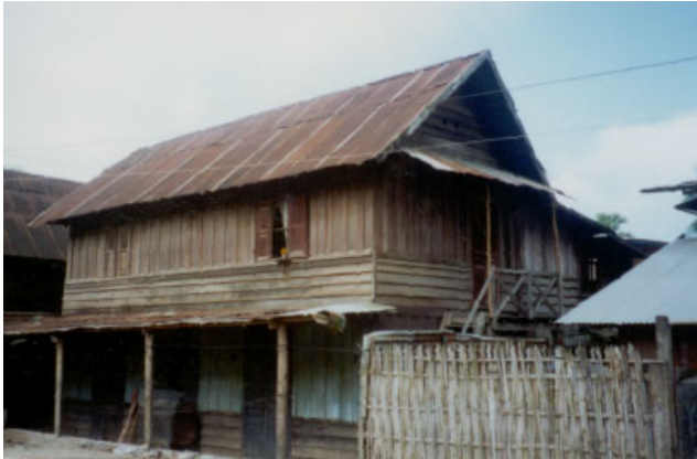
ປະເພດ Typologie ຮູບບ້ານ Village ວິຊຸນ VIXUN ເລກທີ່ເຮືອນ No de maison 8/4 ວັດສະດຸກໍ່ສ້າງ Matériaux de construction B ນ້ຳເບີບັນຊີອະນຸລັກ No inventaire 61
