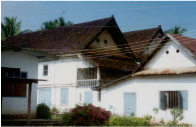
ປະເພດ Typologie ຊຸມຊົນ Village ເລກທີ່ເຮືອນ No de maison ວັດສະດຸກໍ່ສ້າງ Matériaux de construction ນ້ຳເບີບັນຊີອະນຸລັກ No inventaire MEUNNA 39/4 BTBC 187
