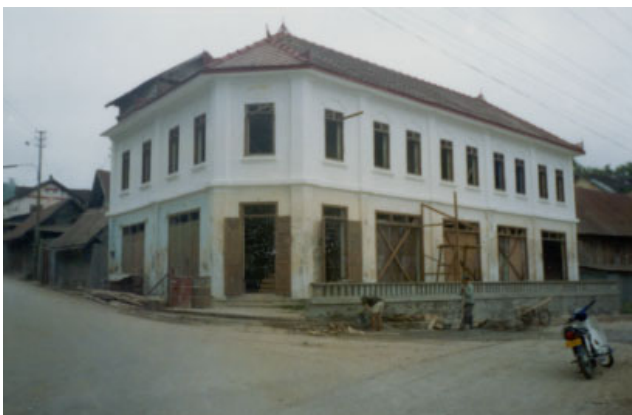
ປະເພດ Typologie ຊຸມນ້ອນ Village ເລກທີ່ເຮືອນ No de maison ວັດສະດຸກໍ່ສ້າງ Matériaux de construction ນ້ຳເບີບັນຊີອະນຸລັກ No inventaire 323
