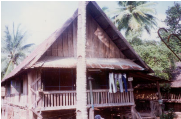
ປະເພດ Typologie ຊຸມຊົນ Village ເທິງຈະເລີນ TONG CHA LEAUNE ເລກທີເຮືອນ No de maison 41/4 ວັດສະດຸກໍ່ສ້າງ Matériaux de construction B ນ້ຳເບີກໍ່ສ້າງ No inventaire 49
