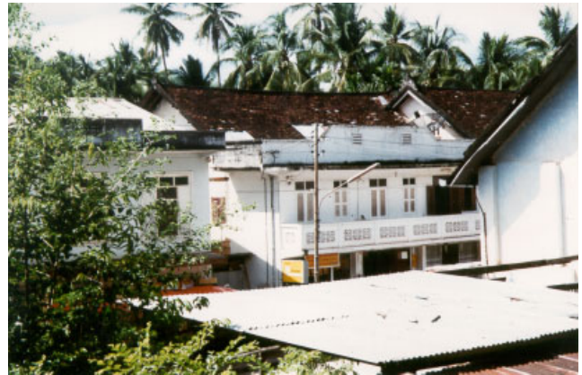
ປະເພດ Typologie ຊຸ້ງບ້ານ Village ເລກທີເຮືອນ No de maison ວັດສະດຸກໍ່ສ້າງ Matériaux de construction ນ້ຳເບີບັນຊີອະນຸລັກ No inventaire ຈຸນຄ່ອງ CHOUM KHONG 7/7 BBC 224
