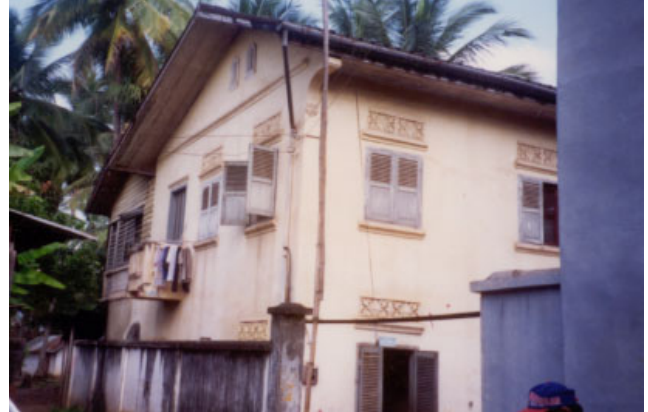
ປະເພດ Typologie ຊຸມນ້ອນ Village ເລກທີ່ເຮືອນ No de maison ວັດສະດຸກໍ່ສ້າງ Matériaux de construction ນ້ຳເບີບັນຊີອະນຸລັກ No inventaire 320
