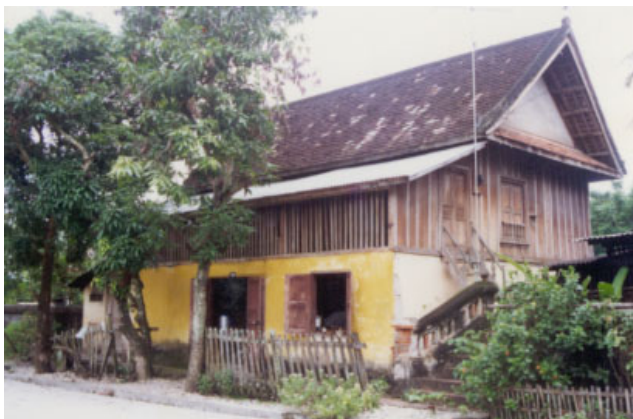
ປະເພດ Typologie ໂພນເຮືອງ Village PHONE HEUANG ເລກທີເຮືອນ No de maison 57/3 ວັດສະດຸກໍ່ສ້າງ Matériaux de construction BC ນ້ຳເບີບັນຊີອະນຸລັກ No inventaire 195
