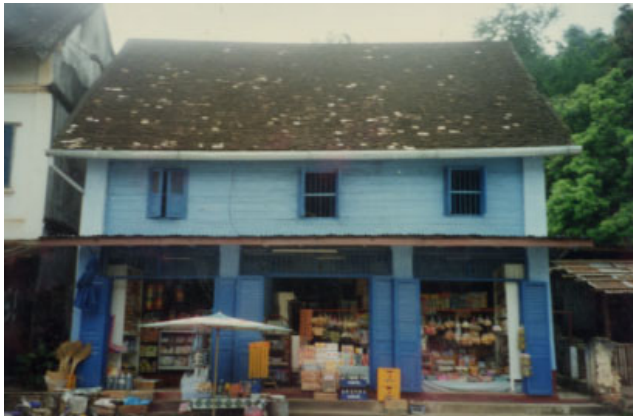
ປະເພດ Typologie ຊຸ້ງບ້ານ Village ເລກທີເຮືອນ No de maison ວັດສະດຸກໍ່ສ້າງ Matériaux de construction ນ້ຳເບີບັນຊີອະນຸລັກ No inventaire ຈຸນຄ່ອງ CHOUM KHONG 13/7 BBC 225
