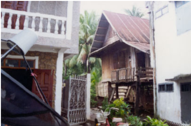
ປະເພດ Typologie ຊຸ້ງບ້ານ Village ເວີດໝອງ VAT NONG ເລກທີ່ເຮືອນ No de maison 7/5 ວັດສະດຸກໍ່ສ້າງ Matériaux de construction B ນ້ຳເບີກຳລັງຂໍອະນຸລັກ No inventaire 9
