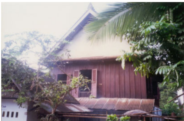
ປະເພດ Typologie ຮູ້ບ້ານ Village ເລກທີ່ເຮືອນ No de maison ວັດສະດຸກໍ່ສ້າງ Matériaux de construction ນ້ຳເບີທີ່ບັນຊີອະນຸລັກ No inventaire 239
