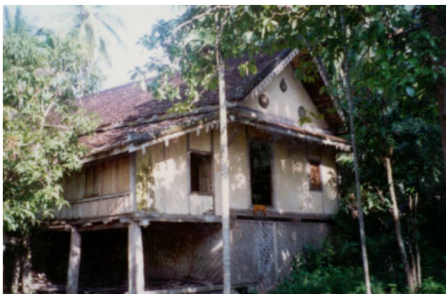
ປະເພດ Typologie ຮູບບ້ານ Village ເລກທີເຮືອນ No de maison ວັດສະດຸກໍ່ສ້າງ Matériaux de construction ນ້ຳເບີບັນຊີອະນຸລັກ No inventaire 119
