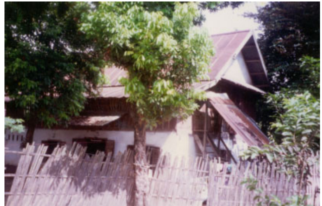
ປະເພດ Typologie ຮູ້ບ້ານ Village ໝື່ນນາ MEUNNA ເລກທີເຮືອນ No de maison * ວັດສະດຸກໍ່ສ້າງ Matériaux de construction BBC ນ້ຳເບີກໍ່ສ້າງ No inventaire 268
