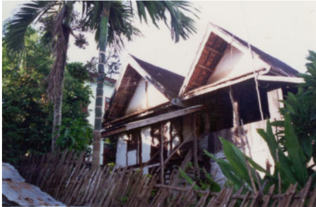
ປະເພດ Typologie ຮູບບ້ານ Village ຄິລີ KHILI ເລກທີເຮືອນ No de maison 31/2 ວັດສະດຸກໍ່ສ້າງ Matériaux de construction BT ນ້ຳເບີບັນຊີອະນຸລັກ No inventaire 103
