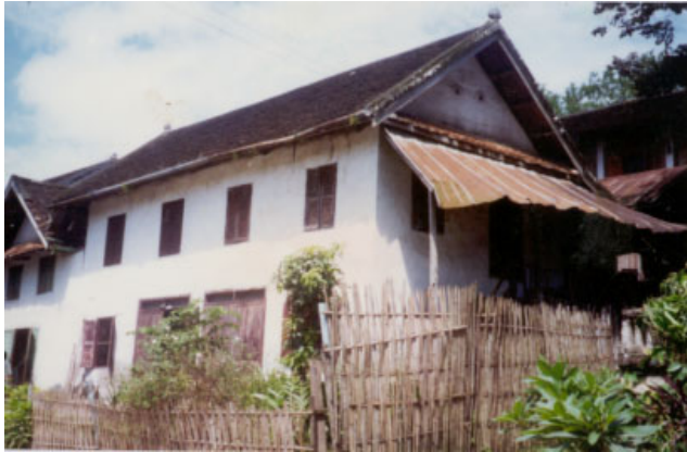
ປະເພດ Typologie ຮູບບ້ານ Village ເລກທີເຮືອນ No de maison ວັດສະດຸກໍ່ສ້າງ Matériaux de construction ນ້ຳເບີບັນຊີອະນຸລັກ No inventaire 115
