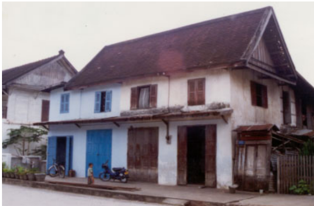
ປະເພດ Typologie ຮູບບ້ານ Village ຄິລີ KHILI ເລກທີເຮືອນ No de maison 38/2 ວັດສະດຸກໍ່ສ້າງ Matériaux de construction BT ນ້ຳເບີບັນຊີອະນຸລັກ No inventaire 105
