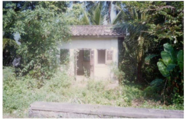
ປະເພດ Typologie ຮູບບ້ານ Village ຊຽງທອງ XIENG THONG ເລກທີເຮືອນ No de maison - ວັດສະດຸກໍ່ສ້າງ Matériaux de construction BC ນ້ຳເບີບັນຊີອະນຸລັກ No inventaire 284
