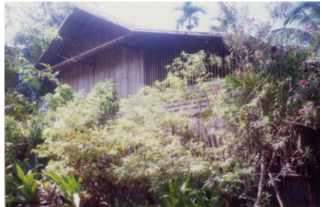
ປະເພດ Typologie ຮູ້ບ້ານ Village ເລກທີເຮືອນ No de maison ວັດສະດຸກໍ່ສ້າງ Matériaux de construction ນ້ຳເບີກໍ່ສ້າງ No inventaire VAT THAT 6/2 B 40
