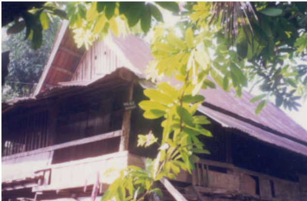
ປະເພດ Typologie ຮູ້ບ້ານ Village ເລກທີເຮືອນ No de maison ວັດສະດຸກໍ່ສ້າງ Matériaux de construction ນ້ຳເບີກໍ່ສ້າງ No inventaire HOUA XIENG 9/1 B 39
