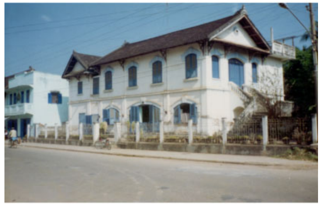
ປະເພດ Typologie ຮູບບ້ານ Village ເວີຂຸນ VIXUN ເລກທີ່ເຮືອນ No de maison 29/4 ວັດສະດຸກໍ່ສ້າງ Matériaux de construction BC ນ້ຳເບີບັນຊີອະນຸລັກ No inventaire 386
