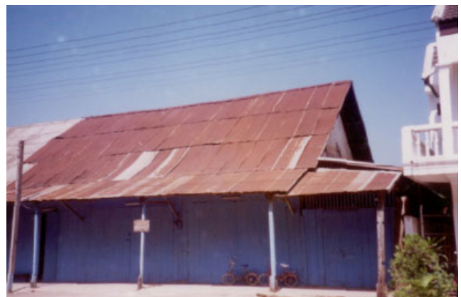
ປະເພດ Typologie ຮູ້ບ້ານ Village ເລກທີເຮືອນ No de maison ວັດສະດຸກໍ່ສ້າງ Matériaux de construction ນ້ຳເບີກໍ່ສ້າງ No inventaire VAT THAT 12/1 B 42
