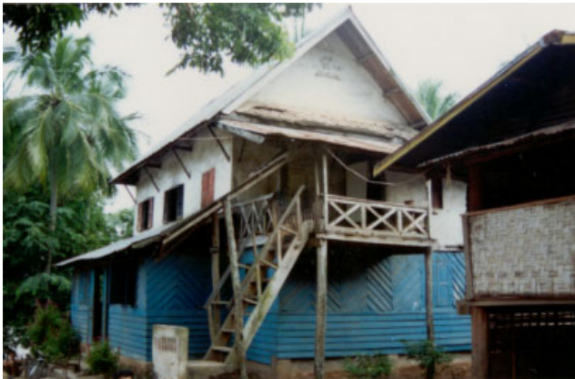
ປະເພດ Typologie ຊຸງໝາຍ XIENG MENE ເລກທີ່ເຮືອນ No de maison 1/7-65 ວັດສະດຸກໍ່ສ້າງ Matériaux de construction BT ນ້ຳເບີກໍ່ສ້າງ No inventaire 165
