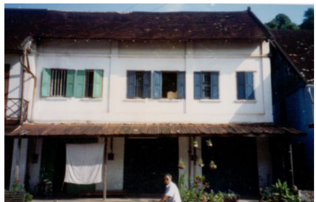
ປະເພດ Typologie ຊຸມຊົນ Village ເລກທີເຮືອນ No de maison ວັດສະດຸກໍ່ສ້າງ Matériaux de construction ນ້ຳເບີກໍ່ສ້າງ No inventaire ຈຸນຄໍ້ອງ CHOUM KHONG 14-15/7 BC 312
