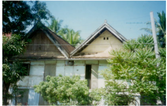
ປະເພດ Typologie ຊຸມຊົນ Village ເລກທີ່ເຮືອນ No de maison ວັດສະດຸກໍ່ສ້າງ Matériaux de construction ນ້ຳເບີບັນຊີອະນຸລັກ No inventaire MEUNNA 21/5 BTBC 188
