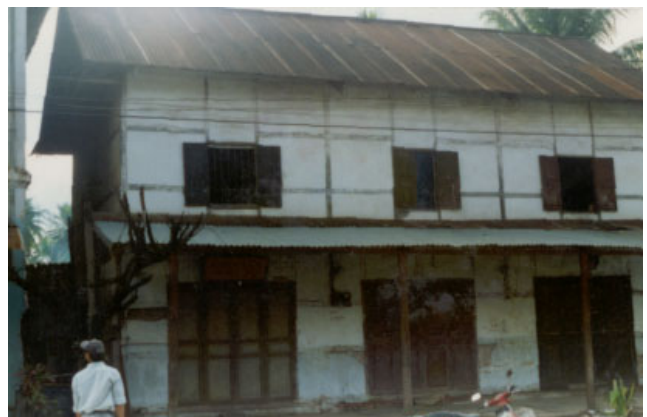
ປະເພດ Typologie ຊຸມຊົນ Village ວຽງແກ້ວ VIENG KEO ເລກທີ່ເຮືອນ No de maison - ວັດສະດຸສ້າງ Matériaux de construction BT ນ້ຳເບີທີ່ຊຶ່ງຂະໜາດ No inventaire 144
