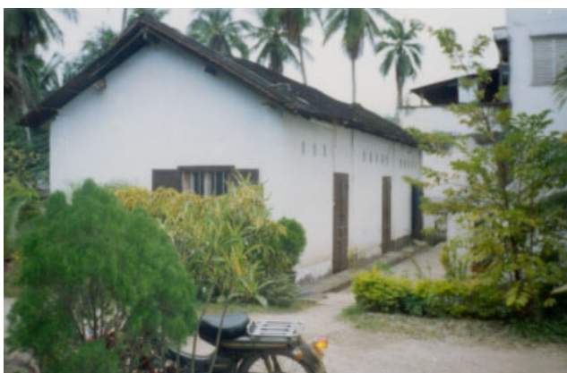
ປະເພດ Typologie ຮູບບ້ານ Village ເລກທີ່ເຮືອນ No de maison ວັດສະດຸກໍ່ສ້າງ Matériaux de construction ນ້ຳເບີບັນຊີອະນຸລັກ No inventaire 365
