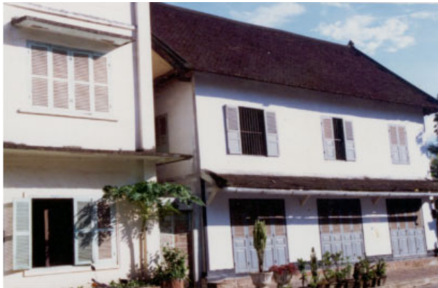
ປະເພດ Typologie ຄິລີ KHILI ເລກທີ່ເຮືອນ No de maison - ວັດສະດຸກໍ່ສ້າງ Matériaux de construction BCT ນ້ຳເບີກໍ່ສ້າງ No inventaire 393
