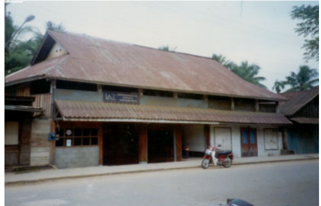
ປະເພດ Typologie ຮູ້ບ້ານ Village ວຽງໄຊ VIENG XAY ເລກທີ່ເຮືອນ No de maison 9-10/1 ວັດສະດຸສ້າງ Matériaux de construction BBC ນ້ຳເບີບັນຊີອະນຸລັກ No inventaire 248
