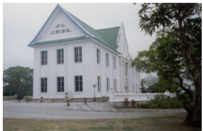
ປະເພດ Typologie ຮູບບ້ານ Village ເລກທີ່ເຮືອນ No de maison ວັດສະດຸກໍ່ສ້າງ Matériaux de construction ນ້ຳເບີບັນຊີອະນຸລັກ No inventaire 366
