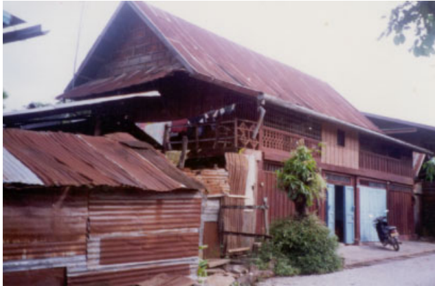
ປະເພດ Typologie ຊຸ້ງບ້ານ Village ເລກທີເຮືອນ No de maison ວັດສະດຸກໍ່ສ້າງ Matériaux de construction ນ້ຳເບີບັນຊີອະນຸລັກ No inventaire CHOUM KHONG 40/7 B 19
