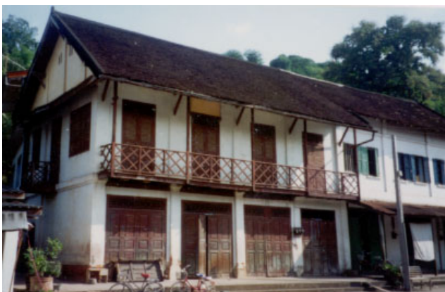
ປະເພດ Typologie ຊຸມຊົນ Village ເລກທີເຮືອນ No de maison ວັດສະດຸກໍ່ສ້າງ Matériaux de construction ນ້ຳເບີກໍ່ສ້າງ No inventaire ຈຸນຄໍ້ອງ CHOUM KHONG 17/7 BC 311
