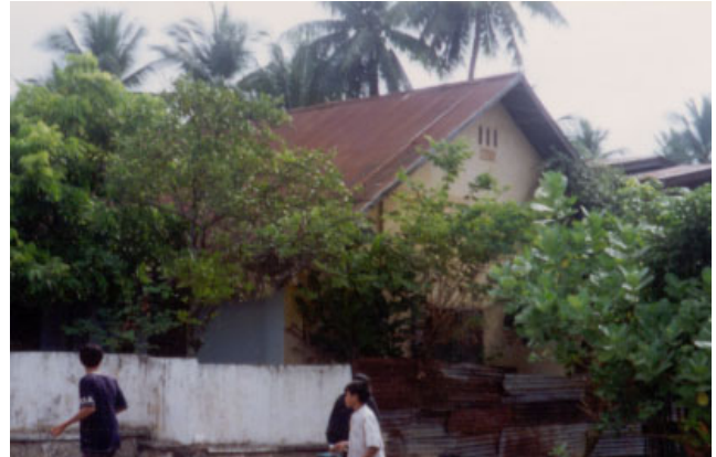
ປະເພດ Typologie ຮູບບ້ານ Village ເລກທີ່ເຮືອນ No de maison ວັດສະດຸກໍ່ສ້າງ Matériaux de construction ນ້ຳເບີບັນຊີອະນຸລັກ No inventaire 362
