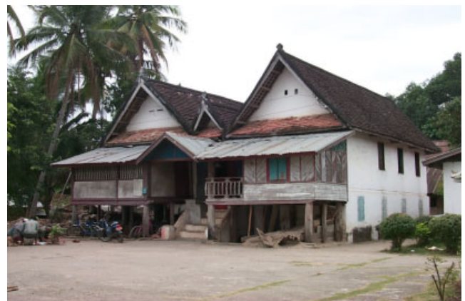
ປະເພດ Type: ວັດ Vat ຈຸມຄ້ອງ Choum Khong BBC ວັດສະດຸໄສ້າງ Matières de construction ນ້ຳເບີກໍ່ຂຶ້ນຂະໜາດ No inventaire 496
