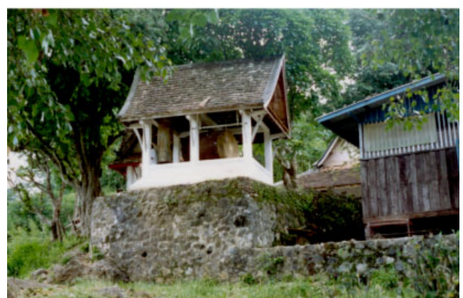
ປະເພດ Type ວັດ Vat ປ່າຝາງ Pafang ວັດສະດຸກໍ່ສ້າງ Matériaux de construction BC ນ້ຳເບີບັນຊີອະນຸລັກ No inventaire 504
