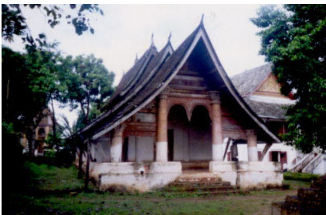
ປະເພດ Type ວັດ Vat ປ່າຝາງ Pafang ວັດສະດຸກໍ່ສ້າງ Matériaux de construction BC ນ້ຳເບີບັນຊີອະນຸລັກ No inventaire 503
